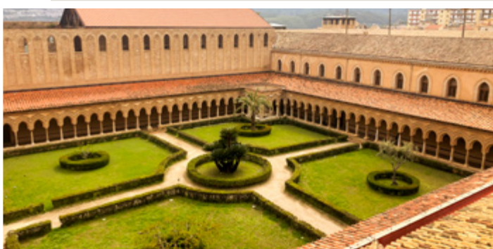
Die Gesamtanlage des Kreuzganges
