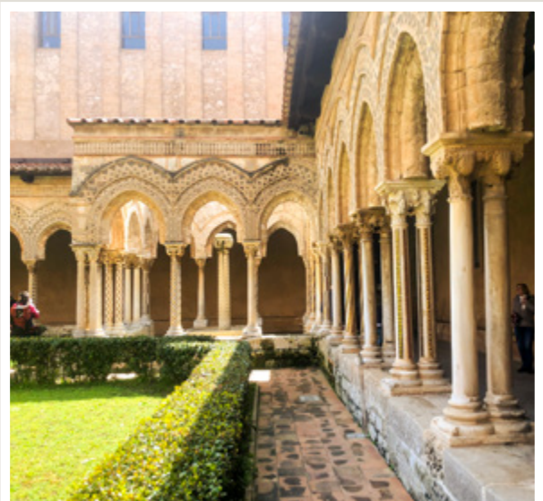
Die Zwillingsssäulen mit den Steinmetzarbeiten
